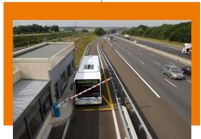
Figure 20 : Arrêt de bus sur l'autoroute de la gare autoroutière de Briis-sous-Forges
