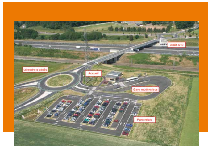
Figure 19 : Parking et pôle d'échange avec les bus locaux sur la gare autoroutière de Briis-sous-Forges
