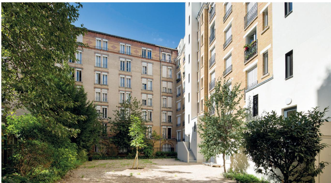
42 logements, construits dans les années 30, situés 19 rue Daubenton - Paris 5<sup>e</sup> - Paris Habitat - Chauffage gaz collectif - Réhabilitation Plan Climat achevée en 2022 avec l'emploi de matériaux biosourcés pour l'isolation (paille, lin, liège)
