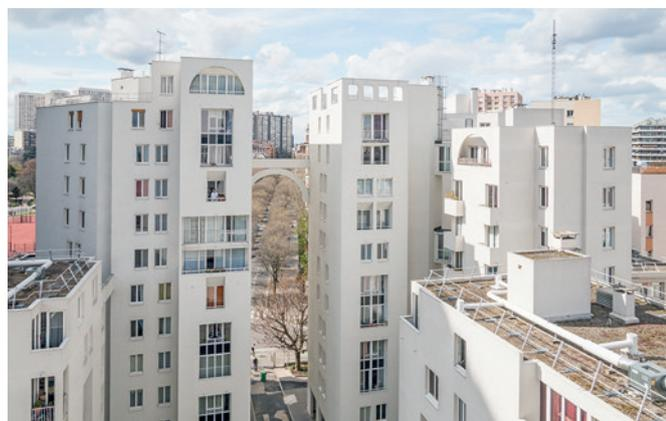
Réhabilitation d'un groupe RIVP avec notamment l'isolation par l'extérieur des façades, le remplacement des menuiseries et le changement du chauffage avec un passage de convecteurs électriques vers un raccordement au chauffage urbain qui se traduit par une baisse significative de la consommation d'énergie après travaux qui s'est accentuée en 2022 et surtout 2023.
