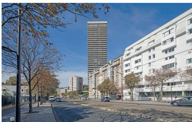
Réhabilitation d'un groupe Paris Habitat avec notamment la mise en œuvre d'une isolation thermique extérieure (ITE), le remplacement des menuiseries et des chaudières qui se traduit par une baisse significative de la consommation d'énergie après travaux qui s'est accentuée en 2022 et surtout 2023 en lien avec l'augmentation du prix du gaz.
