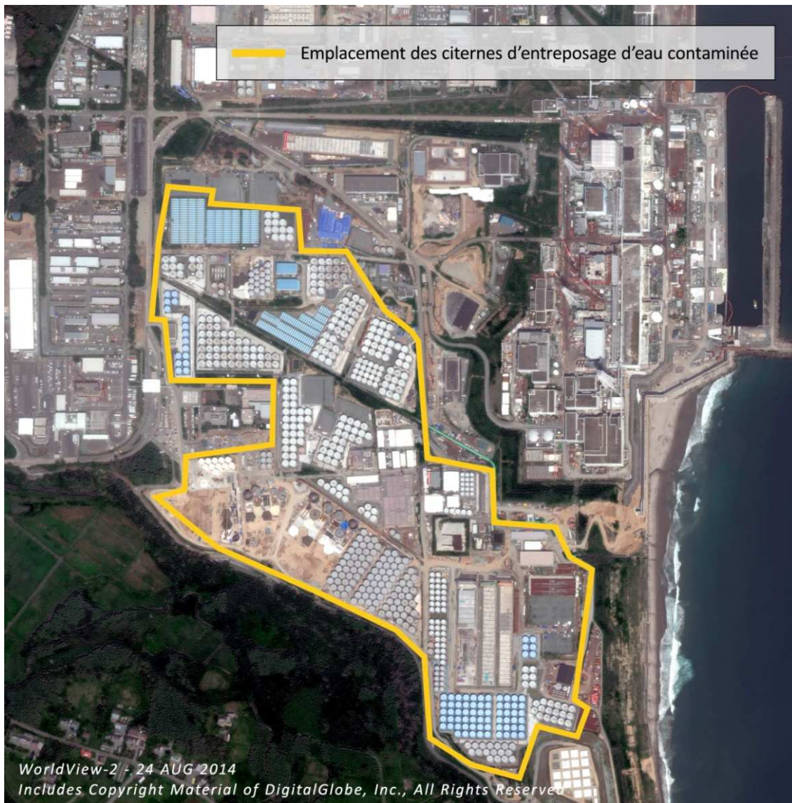
FIG. 5.8. Vue aérienne de la zone du site montrant les citernes d'entreposage de l'eau [301].
