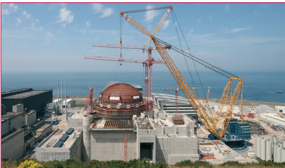
Fig. 4 - Pose du dôme d'EPR Flamanville 3 en juillet 2013
