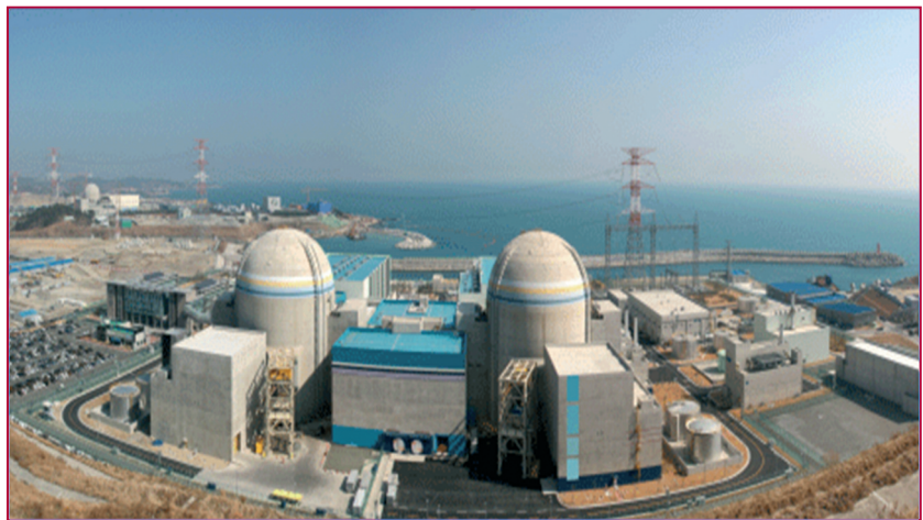
Fig. 5 - Vue des réacteurs APR 1400 en construction à Shin Kori
