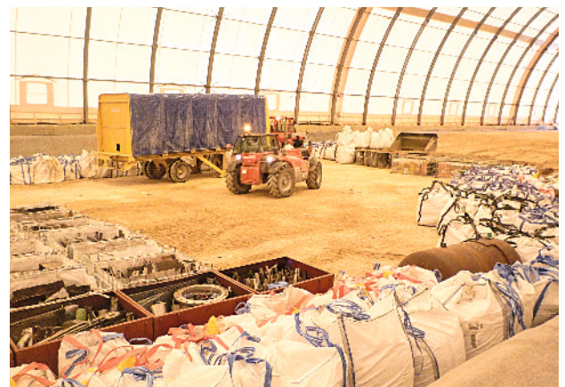
Alvéole de stockage de déchets TFA
