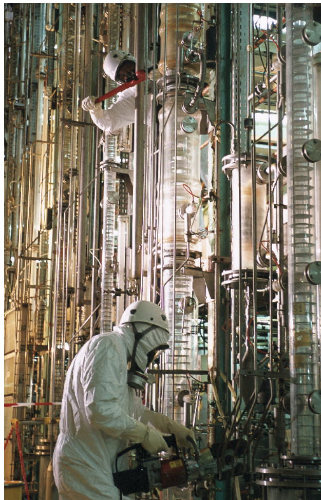
Démantèlement d'une installation prototype d'extraction par solvant en colonnes pulsées (INB57) au CEA de Fontenay-aux-Roses
