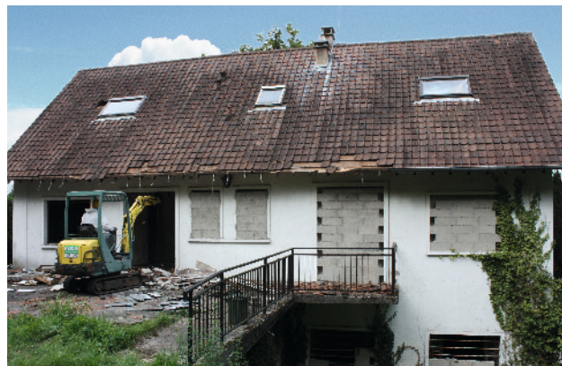
Chantier de démolition d'une maison contaminée à Gif-sur-Yvette
