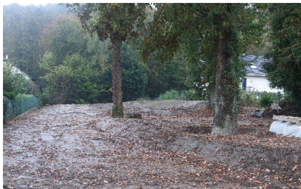
Chantier 1 : après assainissement
