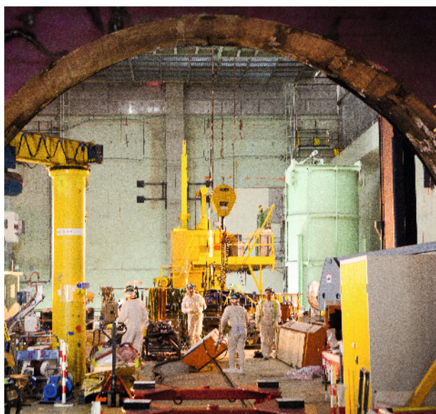
Chantier de déconstruction de la centrale de Chooz A : déconstruction de la caverne
