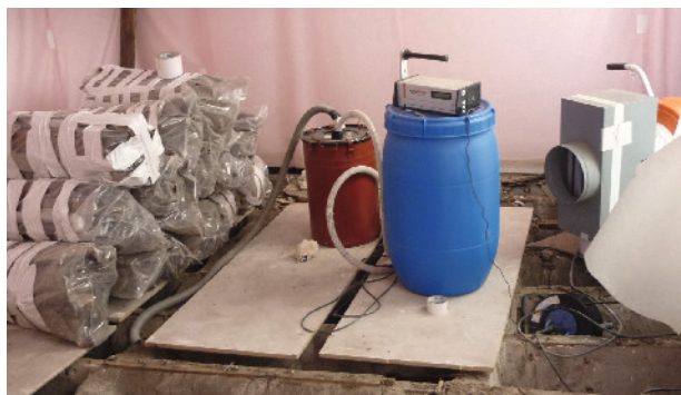
Chantier d'assainissement d'une habitation parisienne (le salon)
