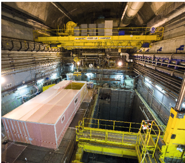
Démantèlement de la centrale Chooz A
