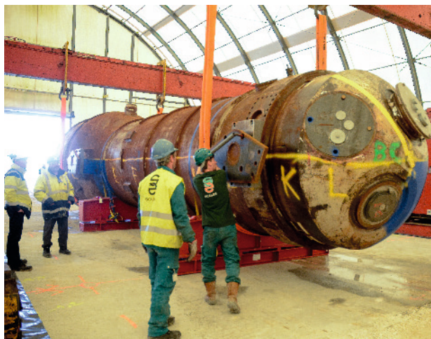
Stockage d'un générateur de vapeur de la centrale de Chooz A au Cires
