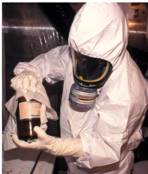
Travaux d'assainissement à l'institut Curie
