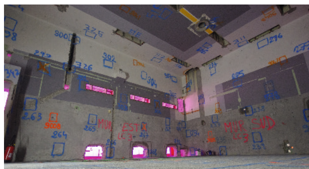
Démantèlement du Lama sur le centre CEA de Grenoble
