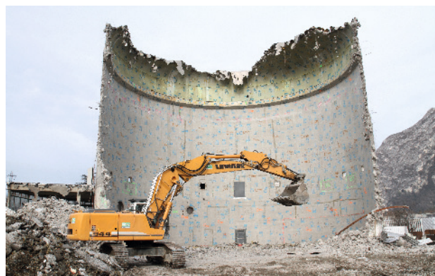
Démantèlement du réacteur Siloé sur le centre CEA de Grenoble
